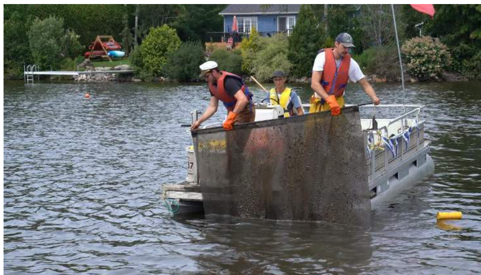
Plateforme flottante qui peut être utilisée à la fin de l'été pour retirer du fond de l'eau une toile de fibre de verre (photographie : Vincent Gagné)
